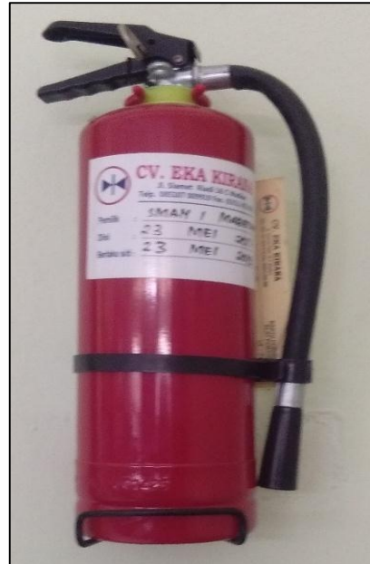
Gambar 3.178 Alat pemadam kebakaran
