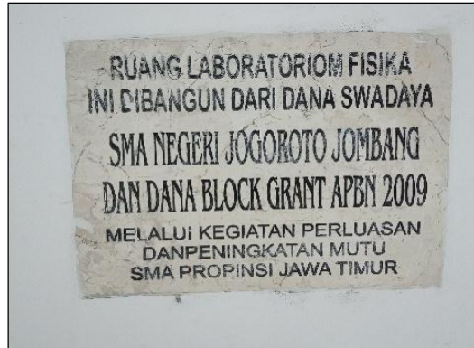
Gambar 3.122 Dinding bagian luar Ruang Laboratorium Fisika
