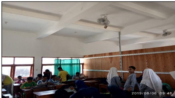
Gambar 3.123 Laboratorium fisika tampak dalam
