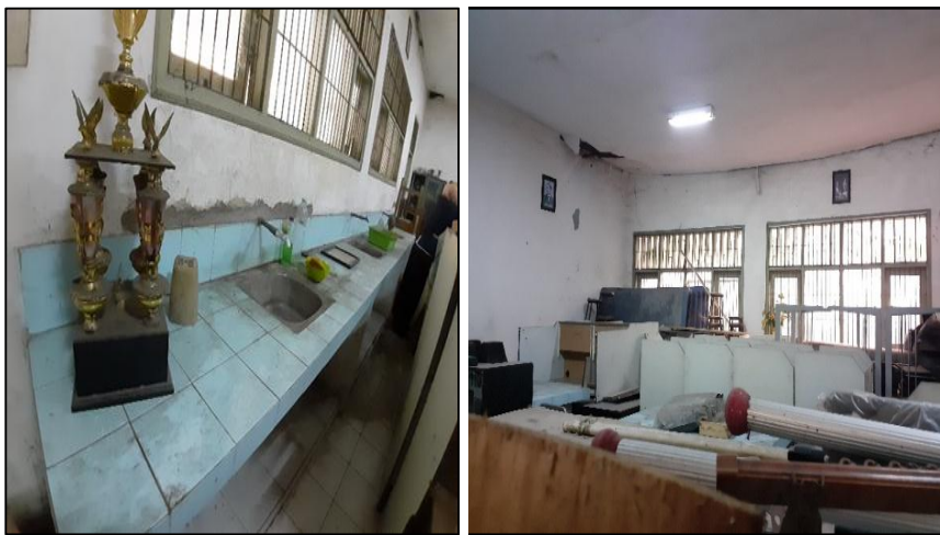
Gambar 3.3 Kondisi wastafel dan bagian tengah ruang
