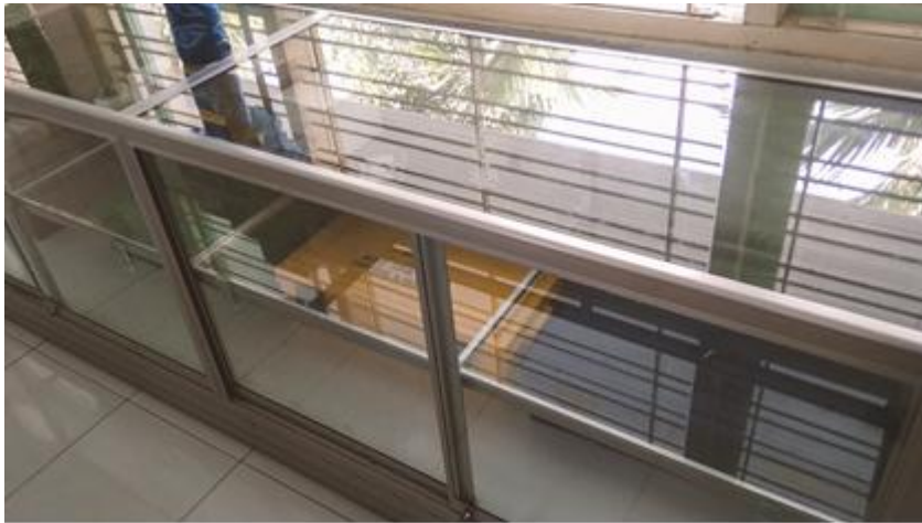
Gambar 3.176 Kondisi alat dalam kotak penyimpanan kaca
